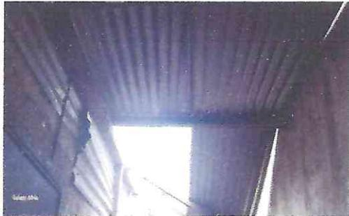
Foto 1. Lamina dañada por los fuertes vientos
