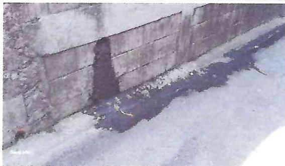
Foto 5. Drenaje de la pila con salida a la calle perjudicando las casas vecinas
